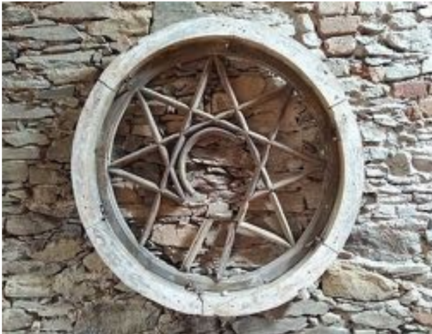
Originalfenster der Synagoge in Hartmanice / Hartmanitz. Foto: Wolfgang Schwarz.
