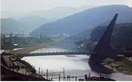
Die von 1995 bis 1998 erbaute Mariánský-Brücke (Mariánský most) in Ústí nad Labem
